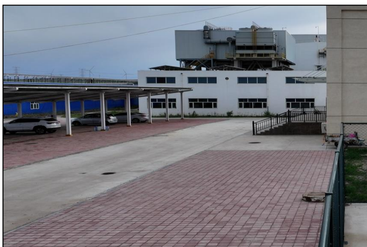
常规岛及生活区透水砖铺设（2024.6）
