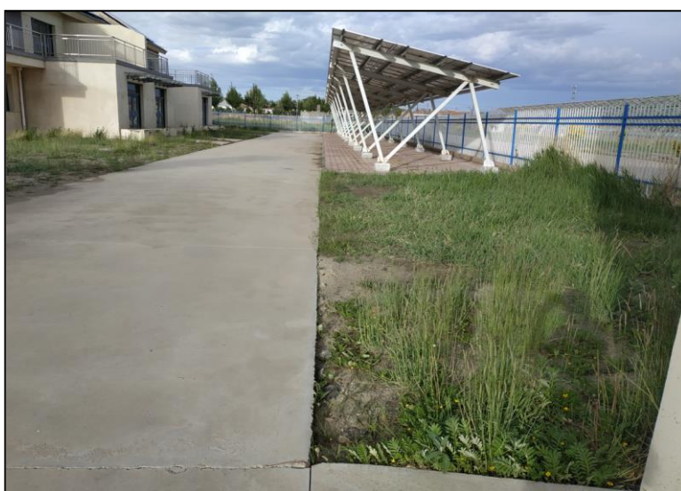
常规岛及生活区透水砖铺设和植被恢复（2024.6）
