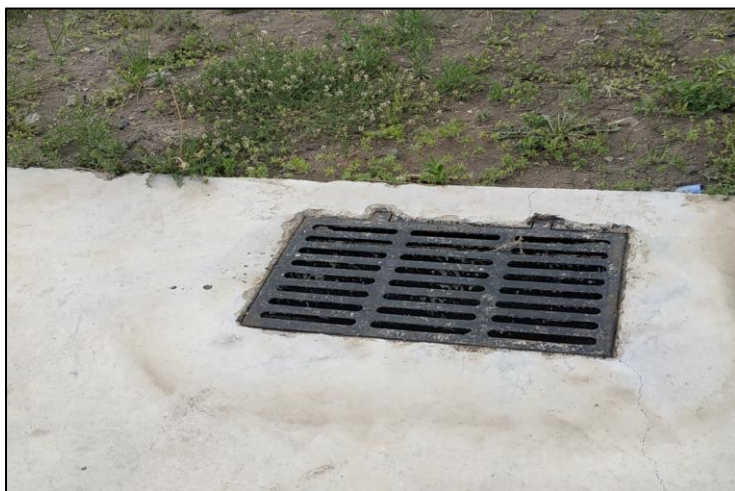
道路区雨水排水管设置雨水口（2024.6）
