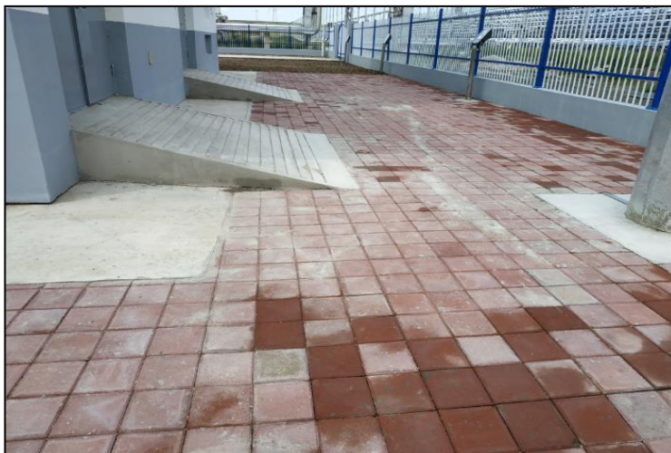
常规岛及生活区透水砖铺设（2020.8）
