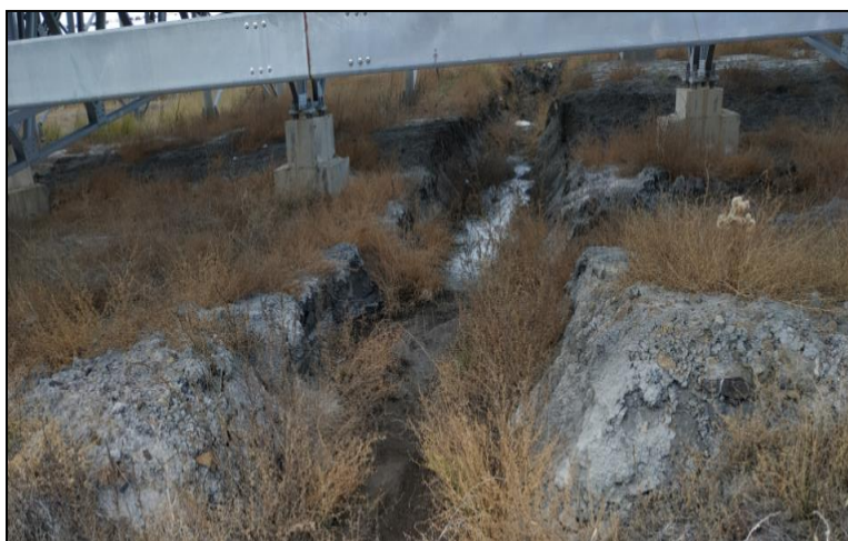
太阳岛纵向土质排水沟和植被恢复（2018.10）
