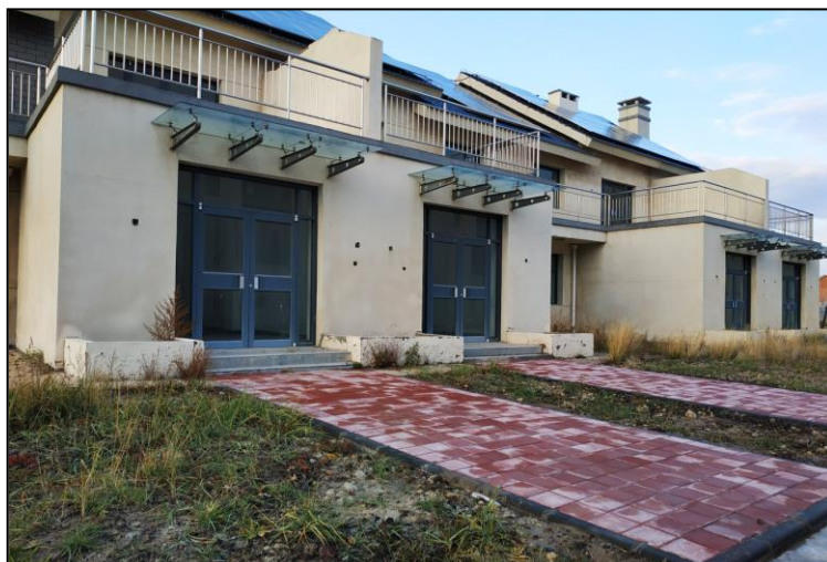
常规岛及生活区铺设透水砖和植被恢复（2023.10）
