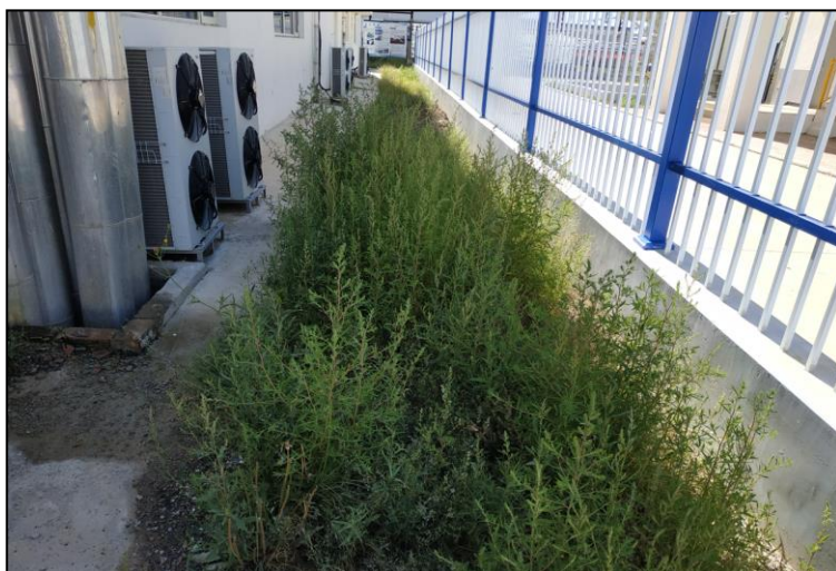
常规岛及生活区自然恢复（2022.8）
