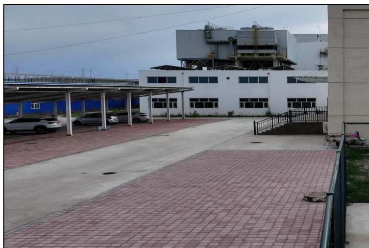
常规岛及生活区透水砖铺设 (2024.6)
