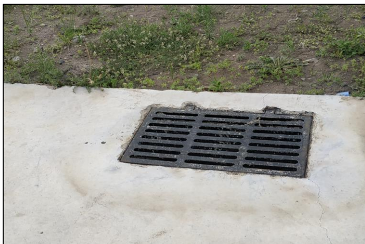
道路区雨水排水管设置雨水口（2024.6）
