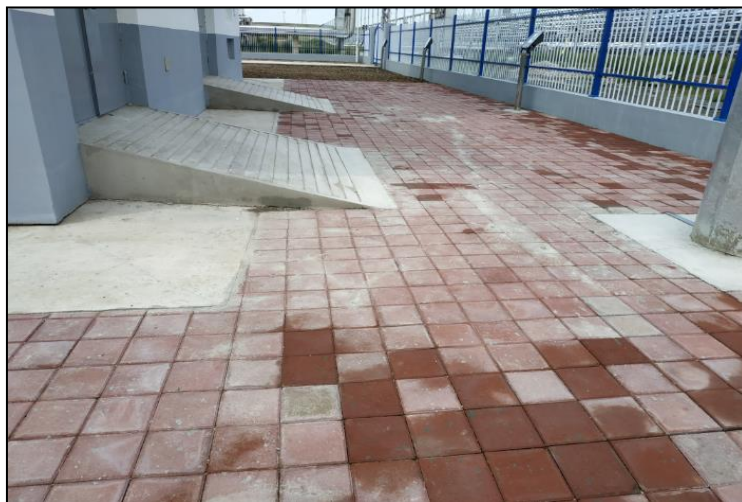
常规岛及生活区透水砖铺设 (2020.8)
