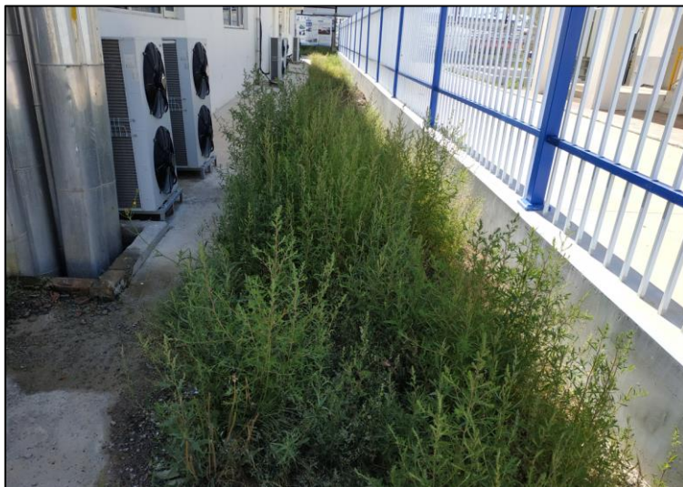
常规岛及生活区自然恢复（2022.8）
