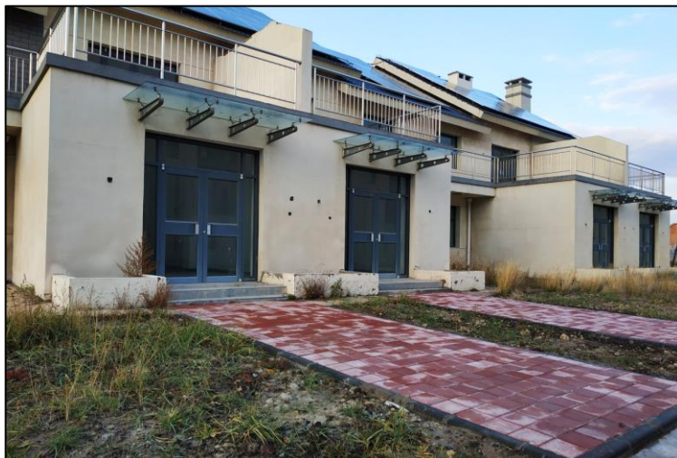
常规岛及生活区透水砖铺设和植被恢复（2024.6）
