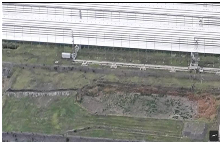
太阳岛蓄水池（2024.6）
