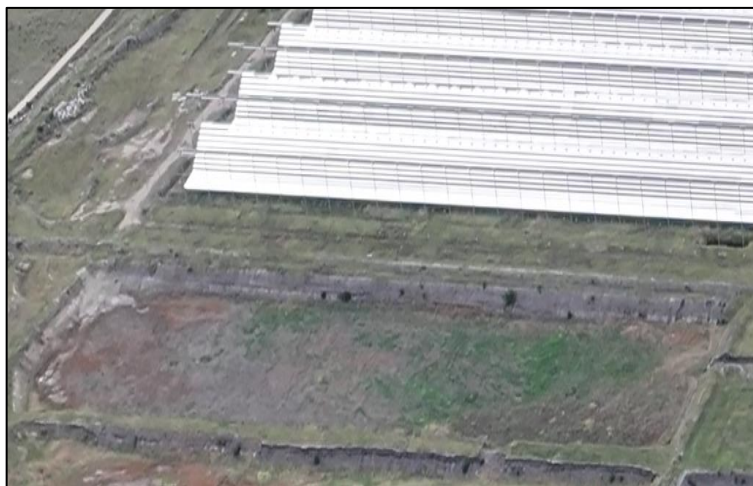
太阳岛蓄水池（2024.6）
