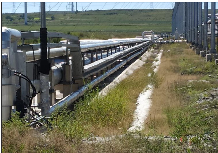
太阳岛混凝土抹面排水沟和植被恢复（2022.8）
